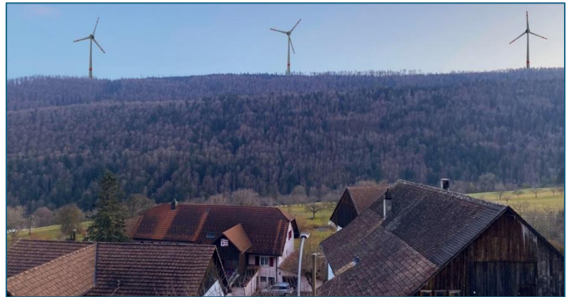
Le parc éolien de la Haute Borne, vu depuis Mettembert
