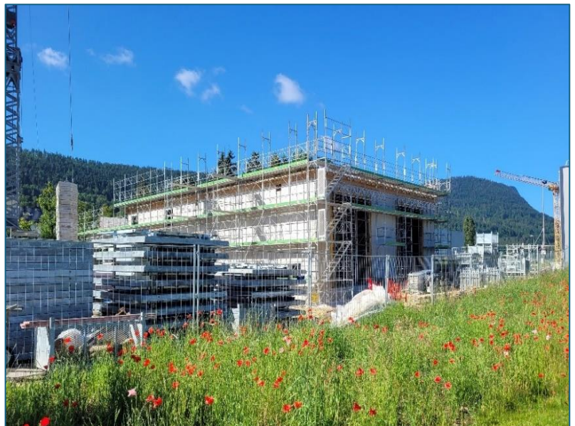
Chantier sous-station Le Day (Photo SOS Jura)
