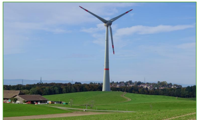
L'éolienne des Saugealles (199 m.) à seulement quelques centaines de mètres des premières maisons de Froideville. Pour voir le film complet de PLCH, cliquez sur l'image
