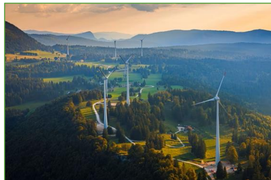
Parc de Ste-Croix, source : Romande Energie
