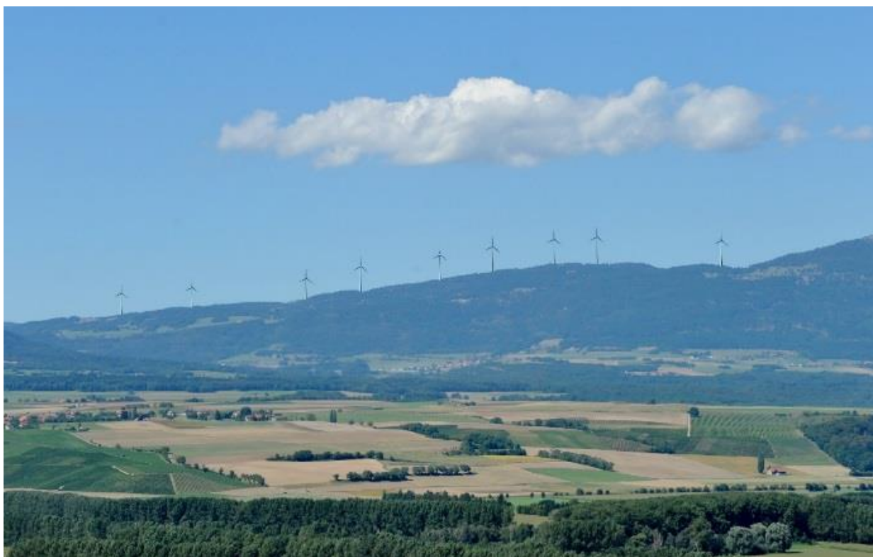
Les neuf éoliennes vues depuis le restaurant de Bavois (photo PLVD). Les habitants des communes qui en font la promotion avec ALPIQ ne les verront pas beaucoup, sauf s'ils se rendent sur le plateau vaudois où habitent des centaines de milliers de personnes.
